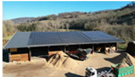
Charavines Plateforme bois CAPV 100kWc
