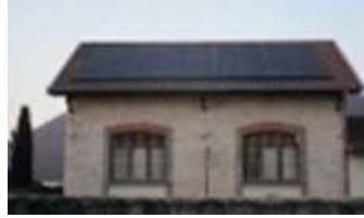
St-Etienne de Crossey - La Poste 9kWc
