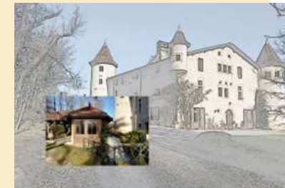
Tullins – Hydro St Jean de Chépy
