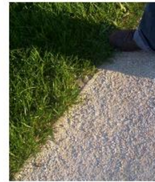
Exemple de volige bois naturel en raccord entre stabilisé et pelouse
