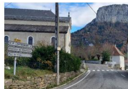
2 Vue de la façade principale de l'église sur rue
